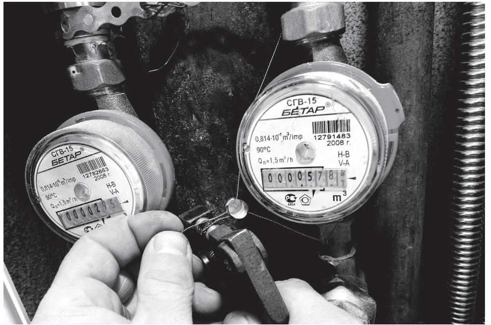
В случае поверки на месте эксплуатации в назначенный день к собственнику на дом придет представитель ФБУ «Приморский ЦСМ» с переносной установкой для проведения поверочных работ.
